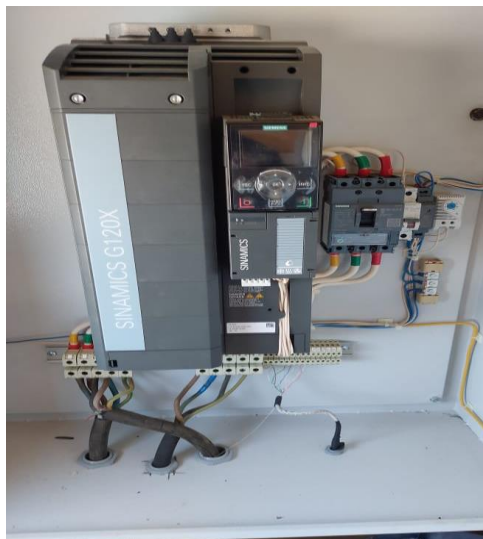
Частотный преобразователь Siemens SINAMICS G120X
